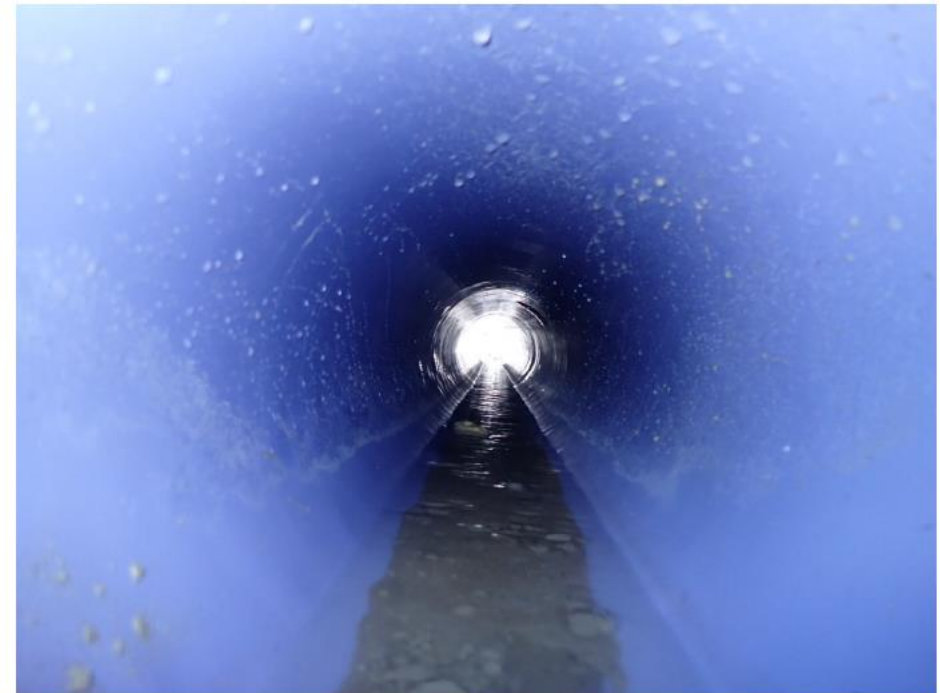
上流側 管渠内状況 施工後
