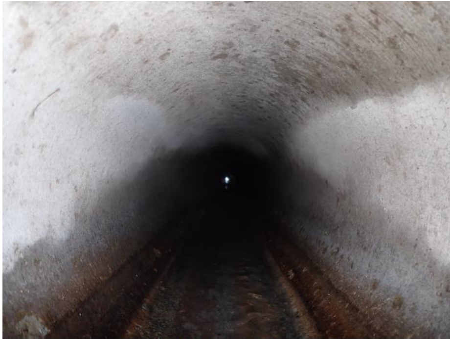
上流側 管渠内状況 施工前
