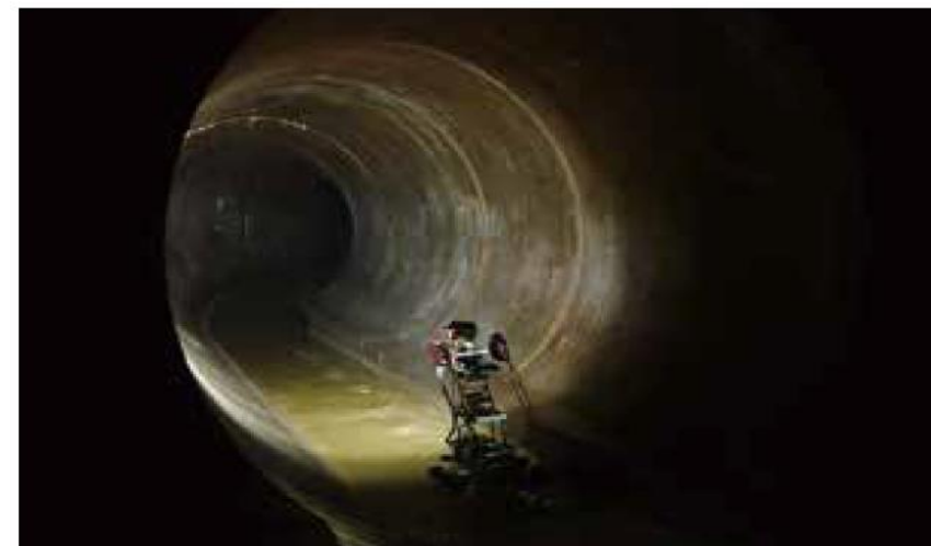
テレビカメラを用いた管路内調査
